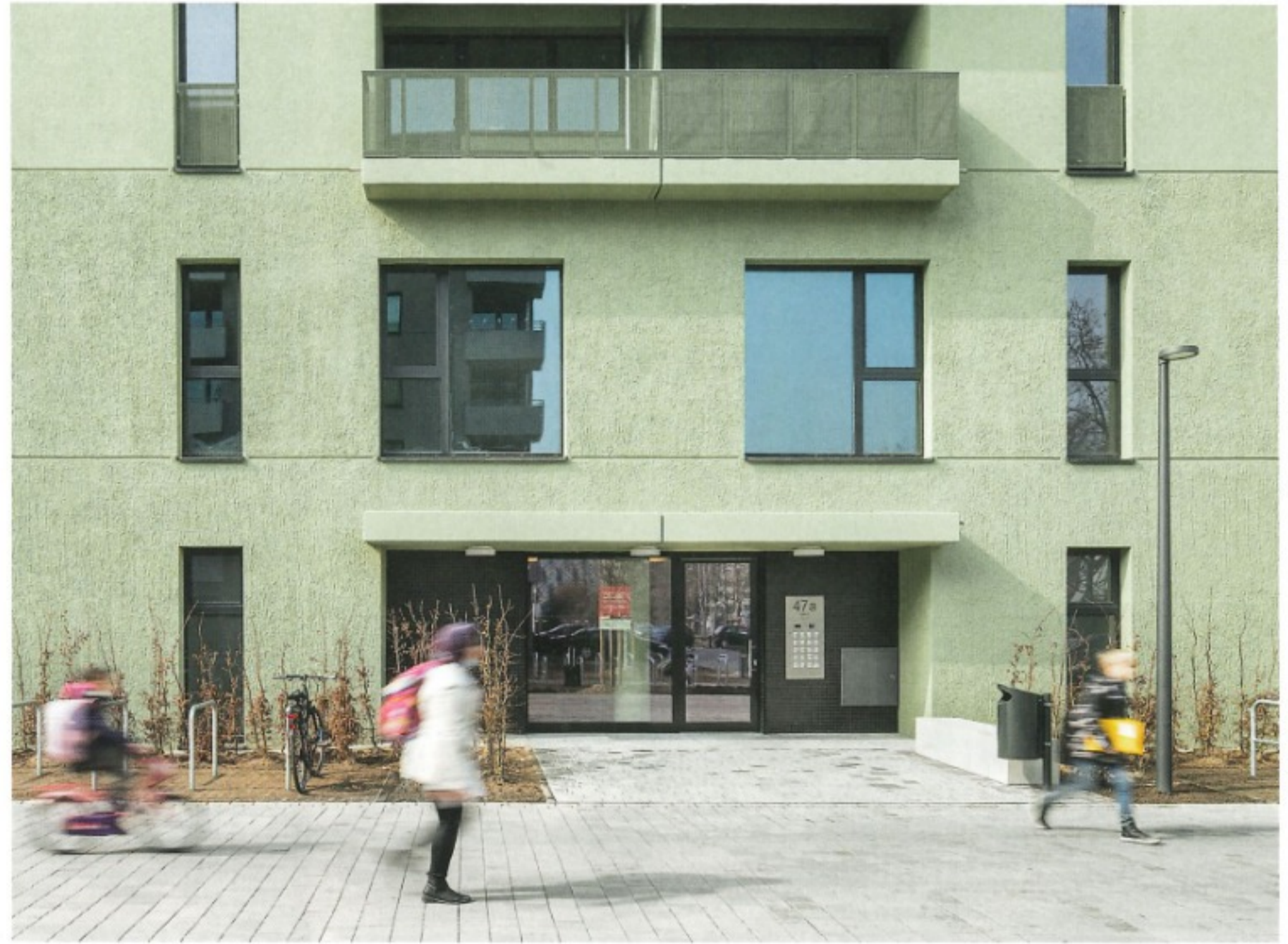
Die sechs Gebäude wurden zum Preis von 1160 Euro pro Quadratmeter BGF (Kostengruppen 300+400) realisiert.
