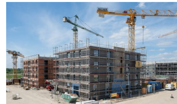
Das erste STADT UND LAND TYPENHAUS eco im Bau
