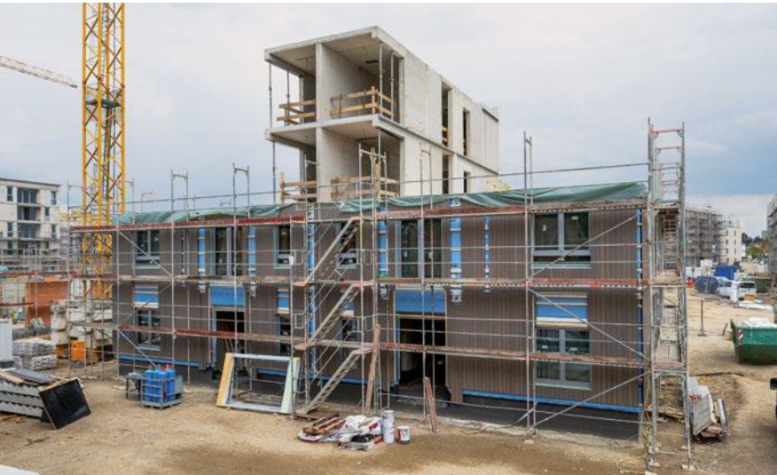
2 | Erschlossen wird das klar strukturierte Gebäude über einen zentralen Treppenkern mit einem Aufzug als Stahlbetonkern. Stand der Holzmontage eineinhalb Wochen nach Baubeginn.
